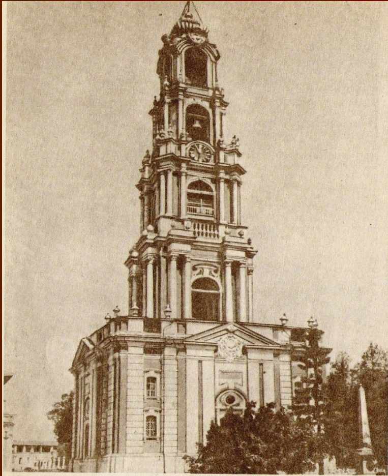
Колокольня Троице-Сергиевой лавры. Архитекторы И. Шумахер, И. Мичурин.
