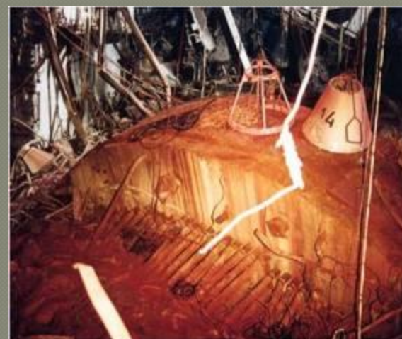
Крышка реактора после взрыва
