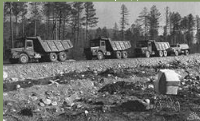
Строителям железных дорог Дальнего Востока
