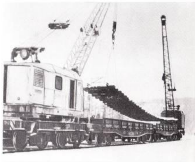
Погрузка готовых звеньев на платформу
