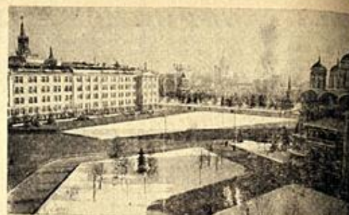
Машинный корпус, Навоиинский завод. Кристалл (вид из Пролетарского Дворца) Фото И. Пролетарского.
