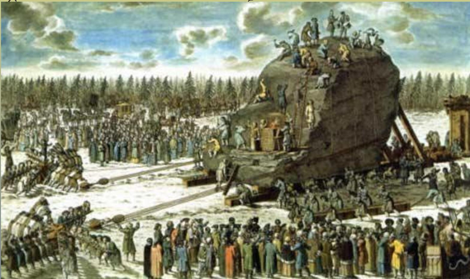
Так подшипники сыграли большую роль в перемещении гром –камня, а условия плавания тел – в доставке его на место.
