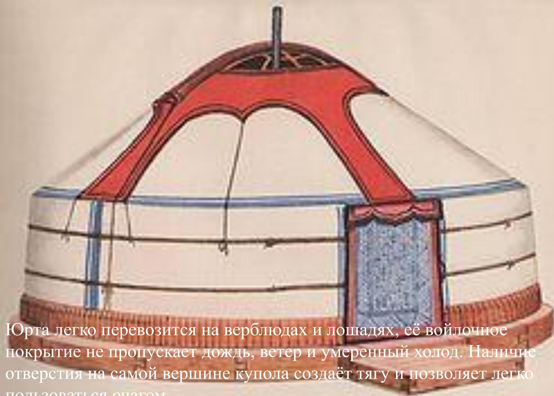
Юрта легко перевозится на верблюдах и лошадях, её войлочное покрытие не пропускает дождь, ветер и умеренный холод. Наличие отверстия на самой вершине купола создаёт тягу и позволяет легко пользоваться очагом.
