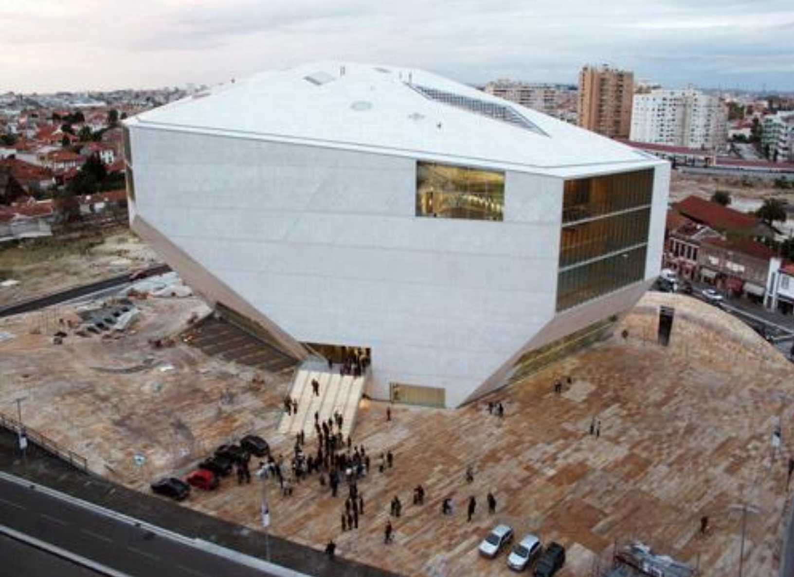
ДОМ МУЗЫКИ (Порту, Португалия) Архитектор: Рем Кулхааст (Rem Koolhaas) Год постройки: 2005
