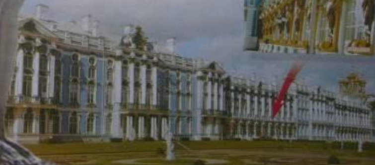
Пожарная опасность Екатерининского Дворца
