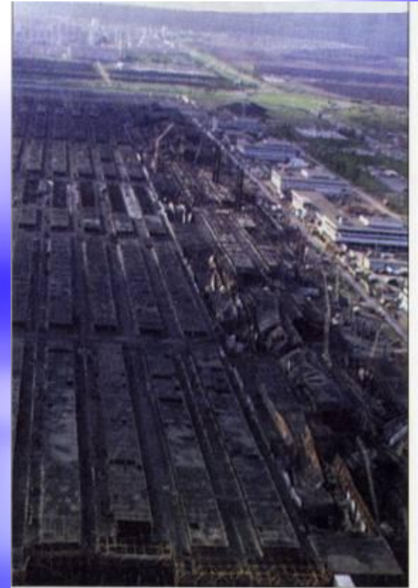
Последствия пожара на заводе двигателей АО «КамАЗ»
