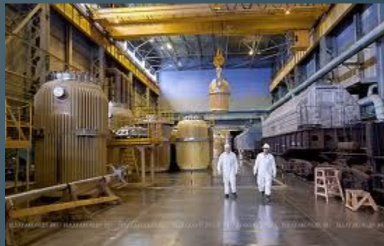
предприятия по переработке или изготовлению ядерного топлива
