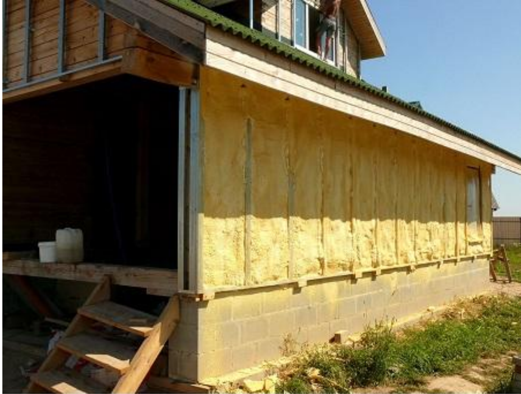
Теплоизоляция террасы снаружи
