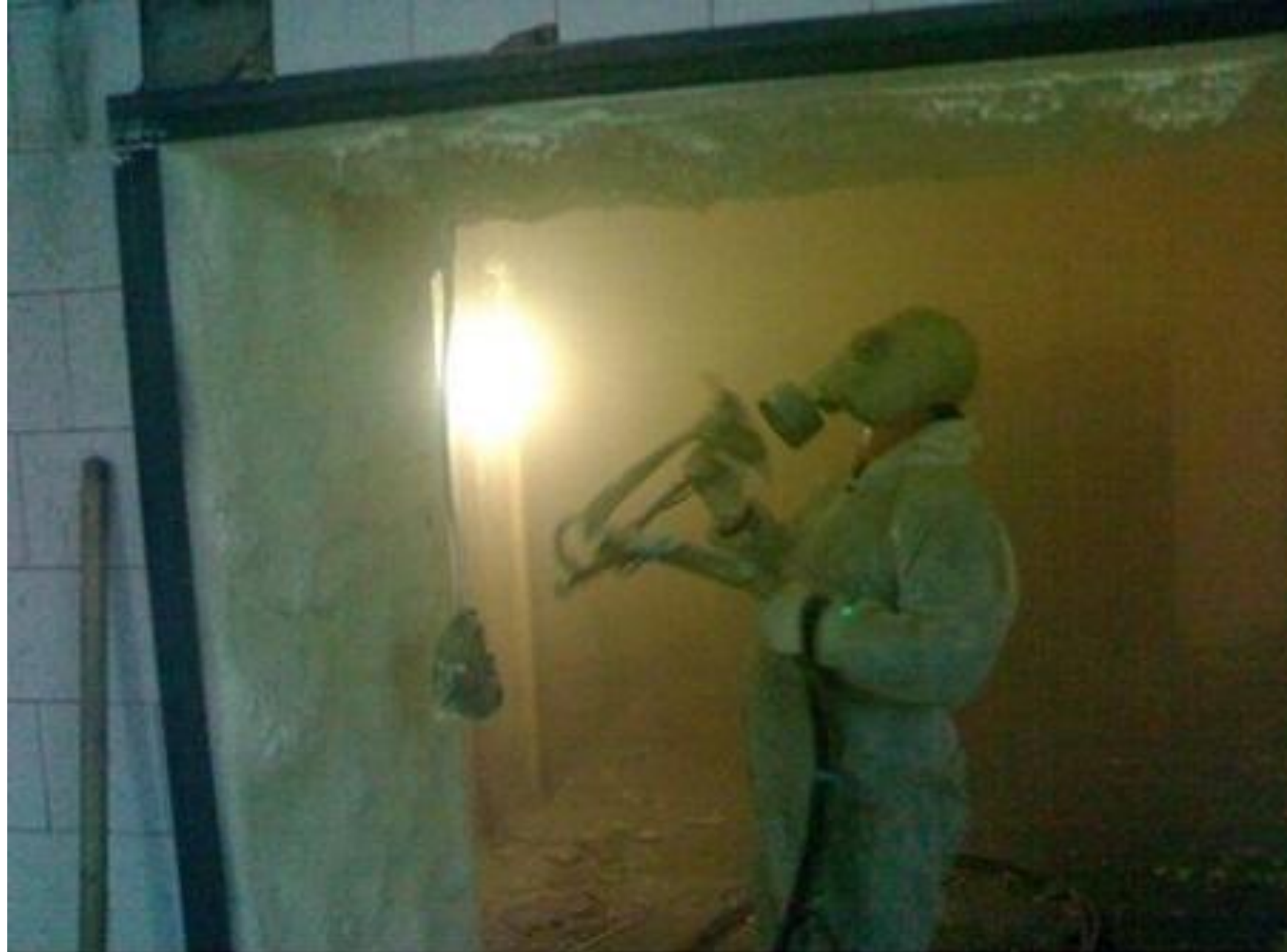
Внутреннее утепление склада
