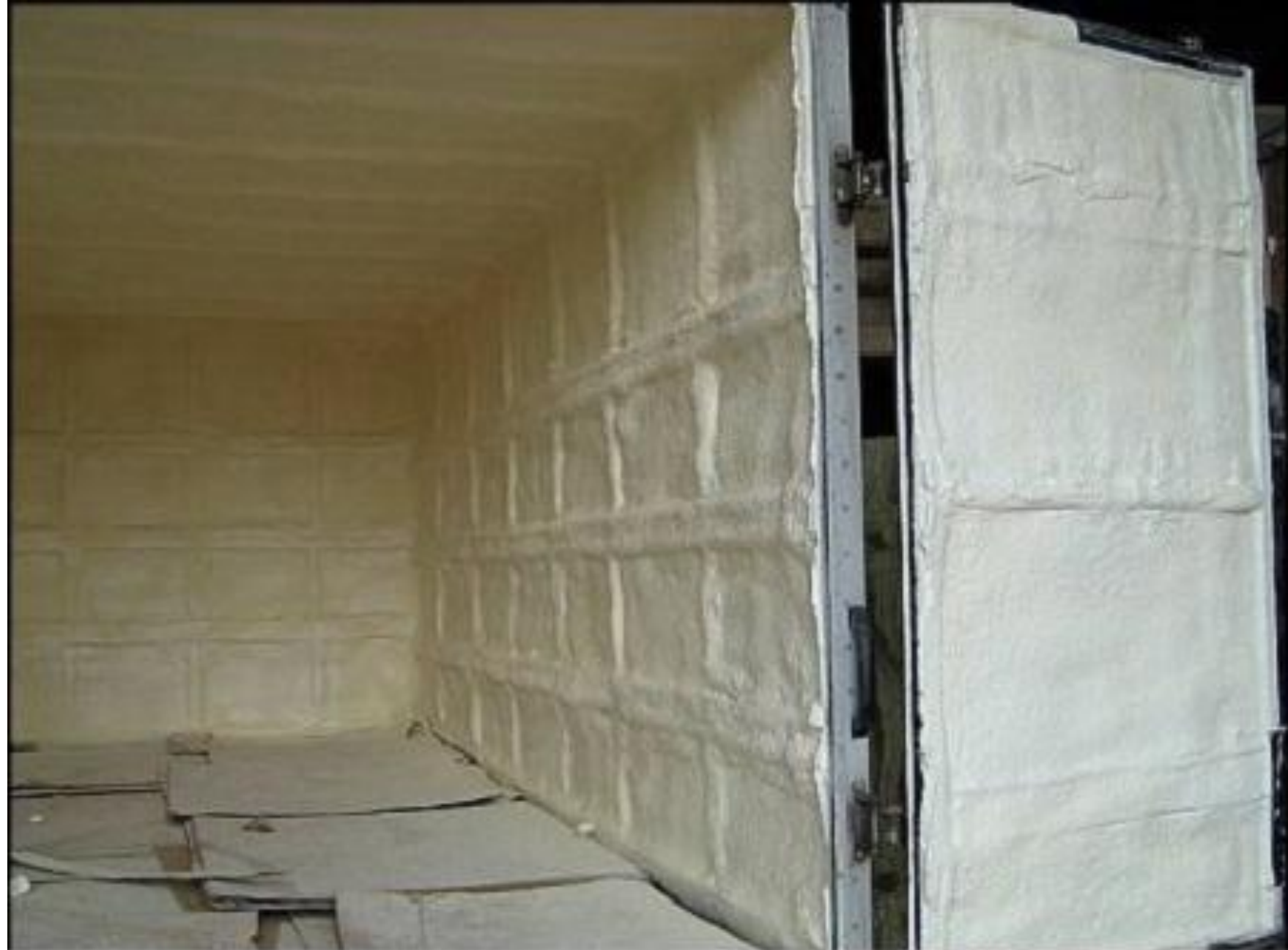
Теплоизоляция холодильной установки изнутри
