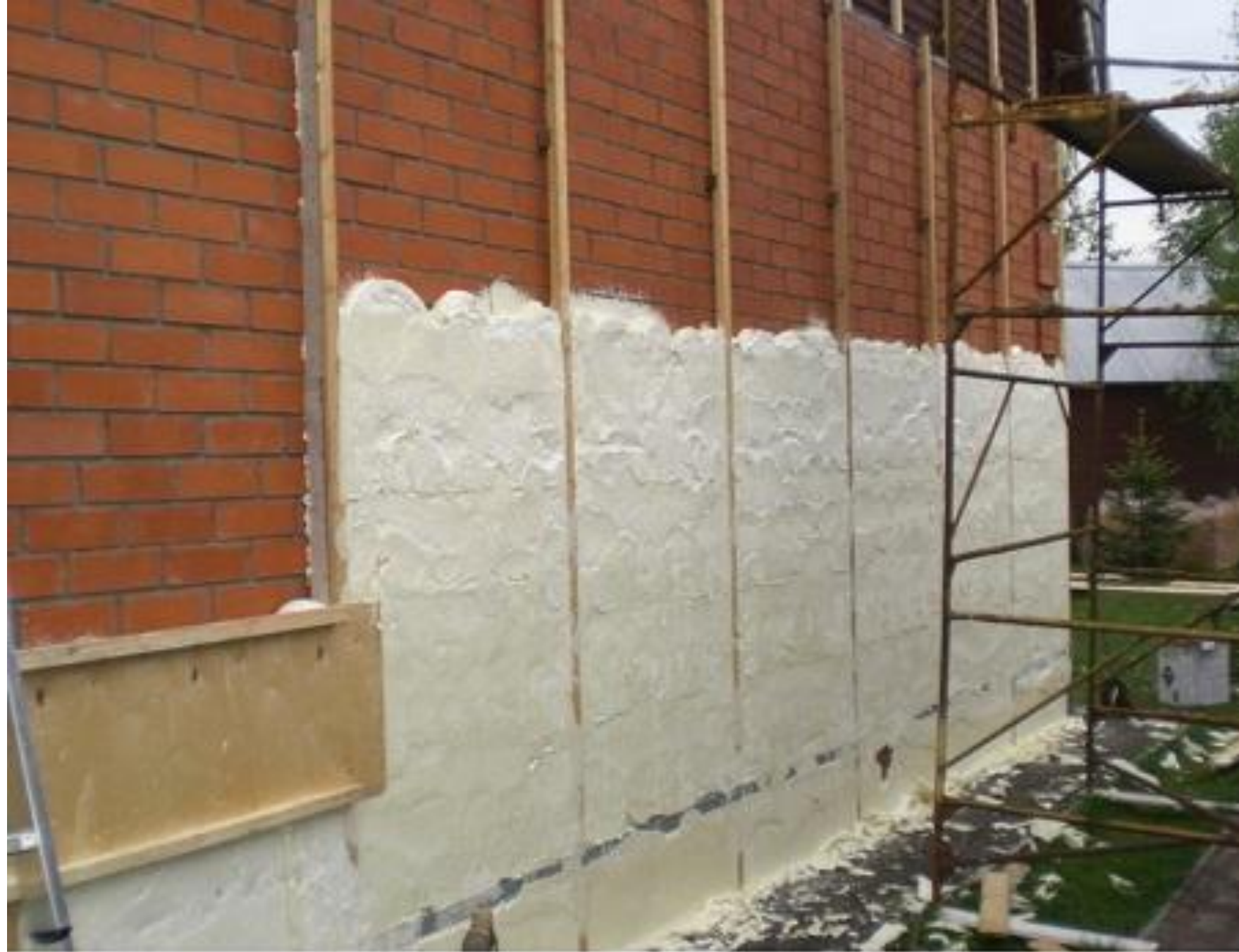
Наружная теплоизоляция стен и цоколя кирпичного дома
