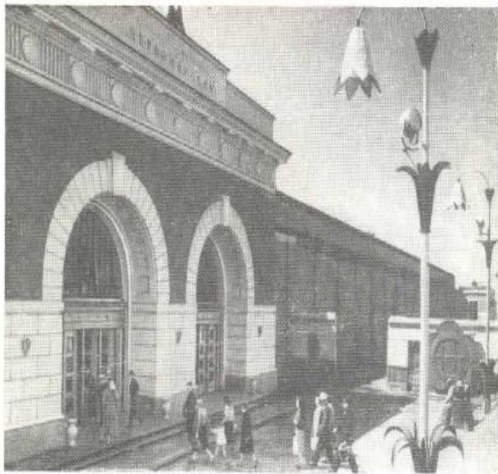
Станция метро «Первомайская».
