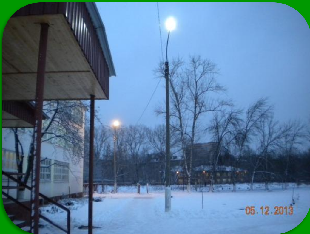
Освещение пришкольной территории
