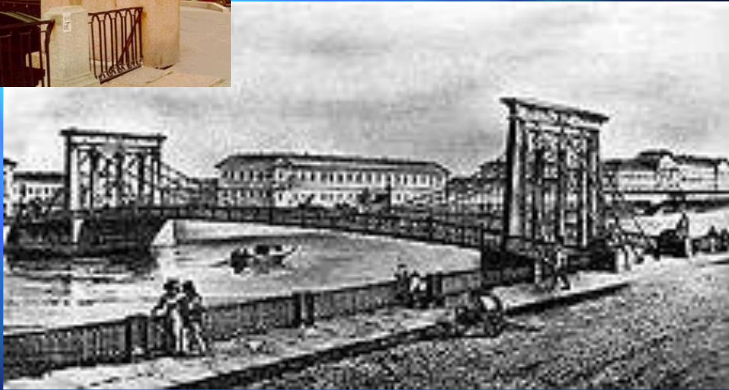
Цепной Египетского моста в Санкт-Петербурге
