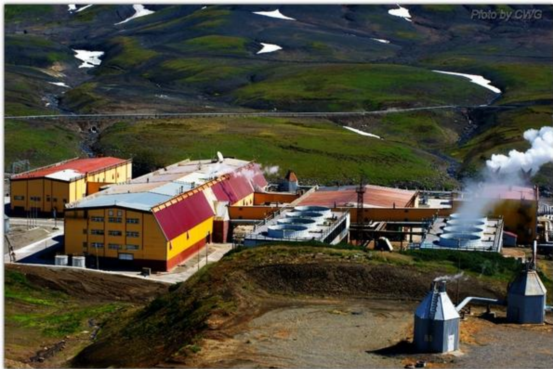
Камчатка - Мутновская Геотермальная электростанция
