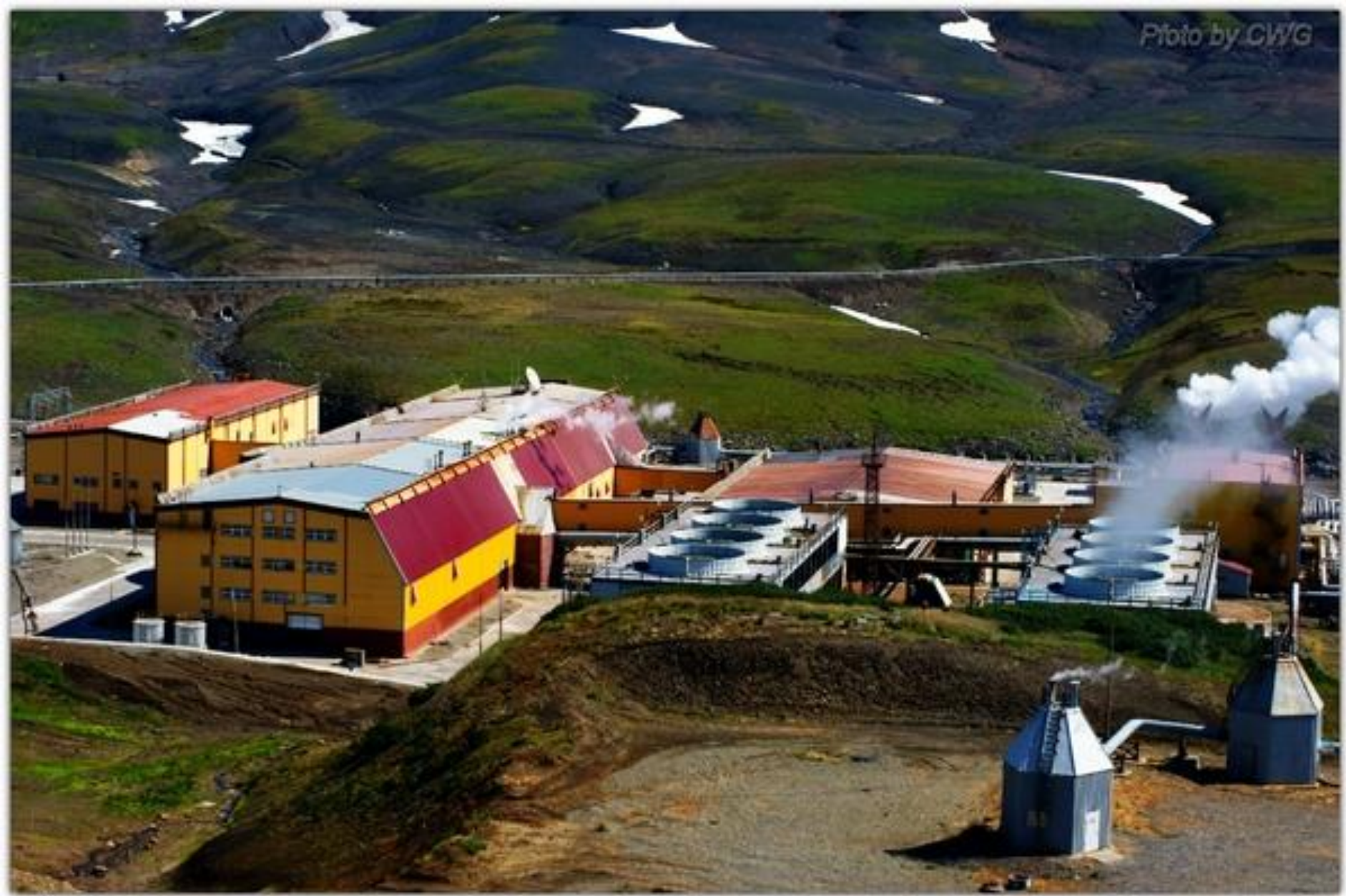
Камчатка - Мутновская Геотермальная электростанция
