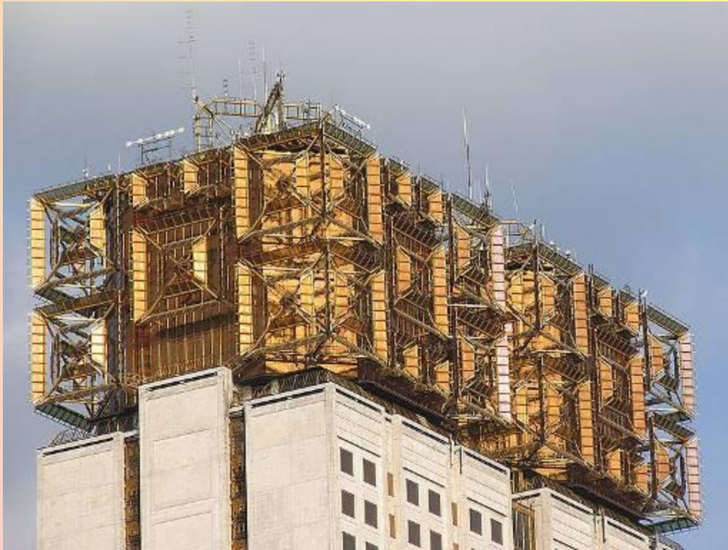
Солнечные батареи на крыше здания Академии наук России
