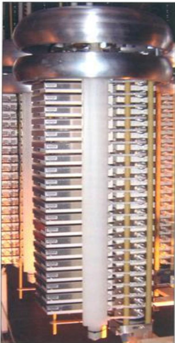
Стандартный IGBT-стек, работающий в ключевом режиме в устройстве статической компенсации реактивной мощности.
