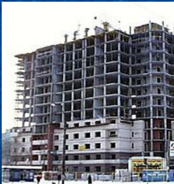
Дом из бетонных панелей
