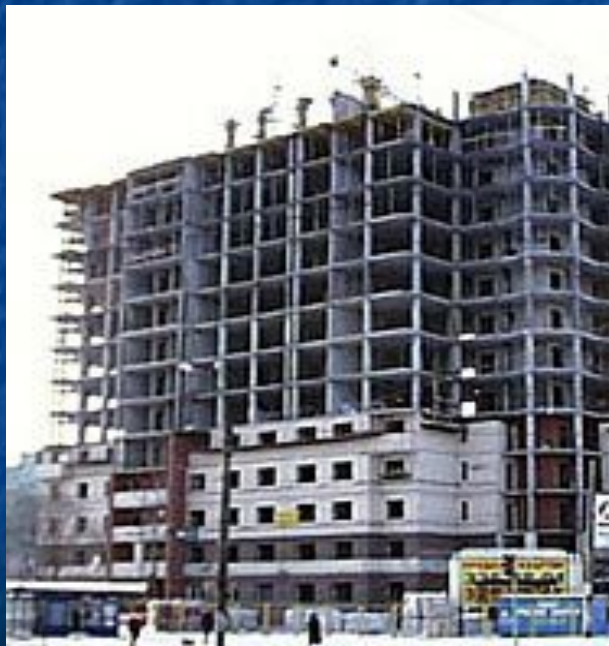
Дом из бетонных панелей
