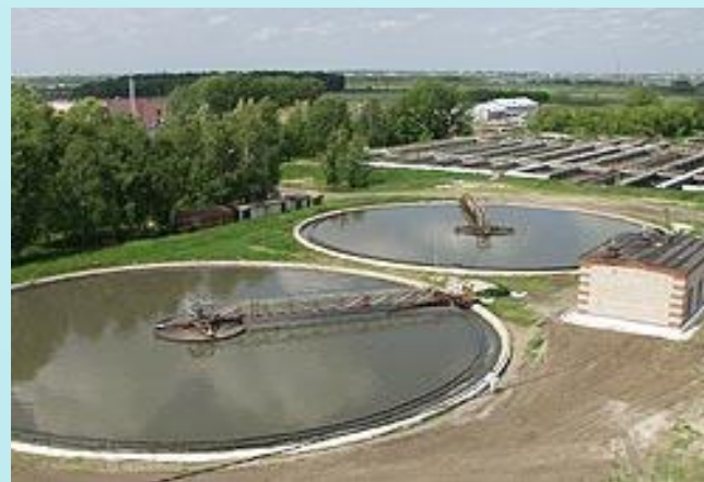
Вертикальный и радиальный отстойники
