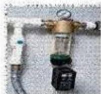
Фильтры комбинированной очистки предназначены для удаления растворенного и нерастворенного в воде железа и солей жесткости.
