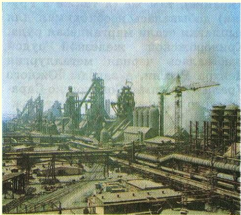
Рис. 37. Доменный цех Магнитогорского металлургического комбината
