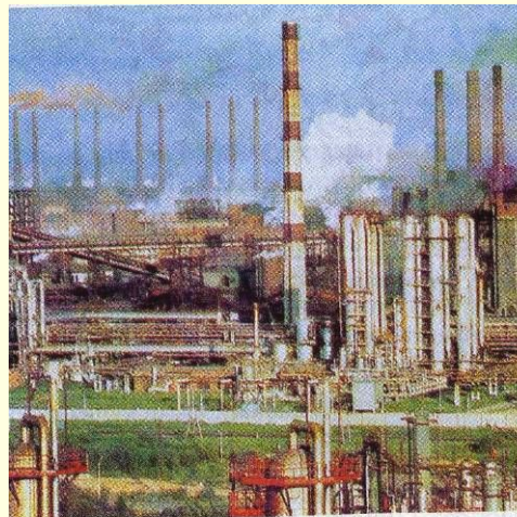
Рис. 36. Металлургический комбинат полного цикла «Северсталь» в Череповце
