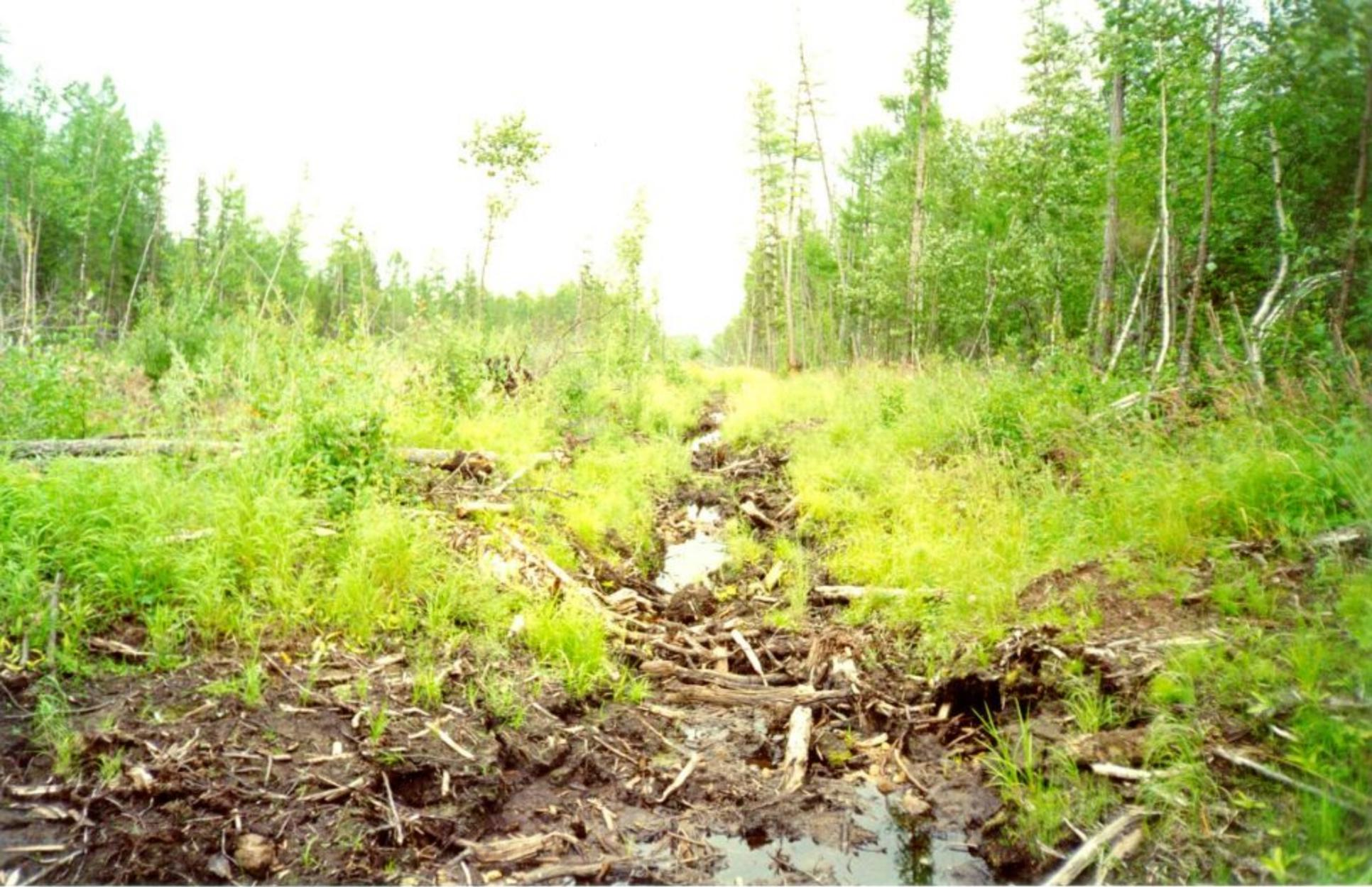
Термоэрозия в сильнольдистых грунтах по вездеходной дороге на просеке нефтепровода
