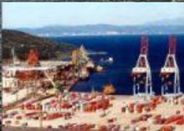
Контейнерный терминал Восточного порта
