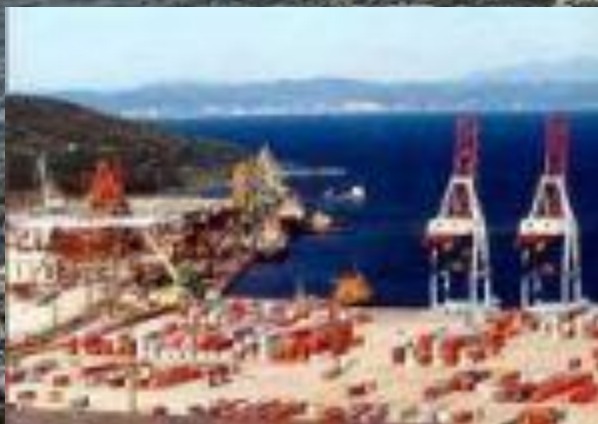
Контейнерный терминал Восточного порта
