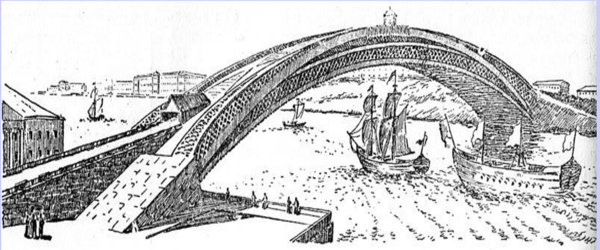
**К 1772 г. Кулибин разработал несколько проектов 300-метрового одноарочного моста через Неву с деревянными решётчатыми фермами. Он построил и испытал большую модель такого моста впервые в практике мостостроения, показав возможность моделирования мостовых конструкций. В последующие годы Кулибин изобрел и изготовил много оригинальных механизмов, машин и аппаратов. Среди них — фонарь-прожектор с параболическим отражателем, речное судно с вододействующим двигателем, передвигающееся против течения**
