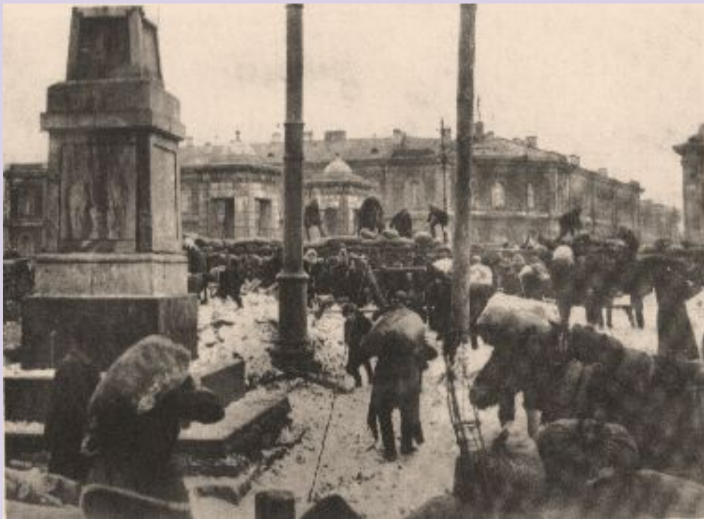
Строительство баррикад в Петрограде
