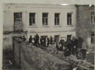
Пионеры на строительстве спортивного зала школы
