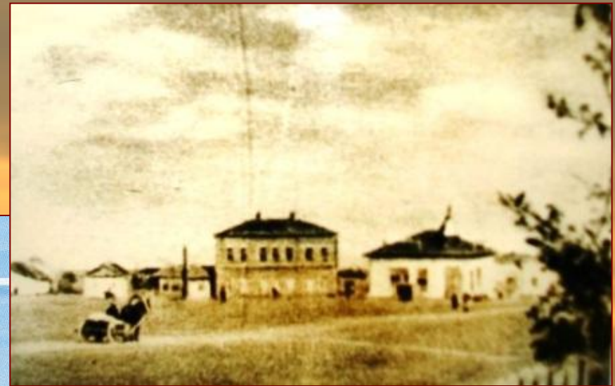
Село Землянки (Алексеевка)
