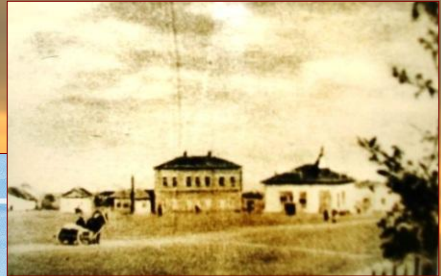
Село Землянки (Алексеевка)
