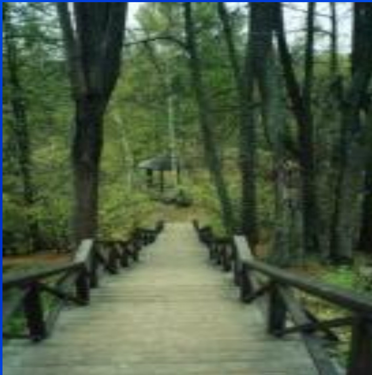
МОСТ ЧЕРЕЗ РЕЧКУ КУЕКШУ
