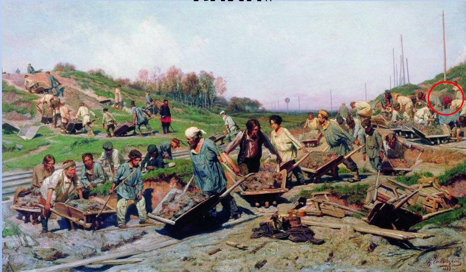
К.А. Савицкий «Ремонтные работы на железной дороге» 1874г.
