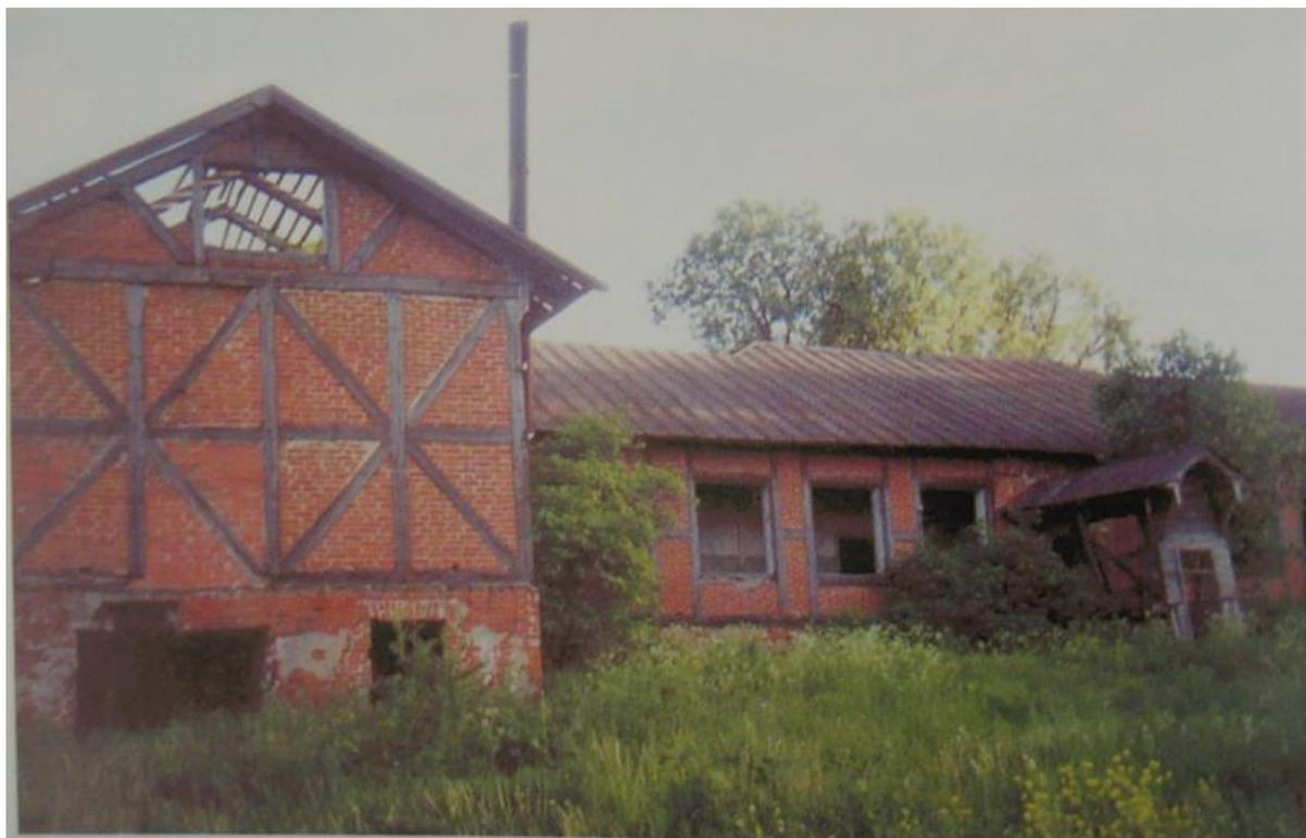
Полуразрушенное П-образное здание больницы. Конструкция здания интересна перекрытиями из дубовых брусьев, заполненных кирпичом. Открылась она в 1858 г. при А.В. Пашкове и просуществовала до 1908 г. 29 лет в ней проработал доктор Э.П. Ассендельфт, заслуживший всеобщее уважение в округе, что было отмечено вручением ему благодарственного адреса сергачским предводителем дворянства П.И. Званцевым. Помощником лекаря работал Д.Д. Матузевич.
