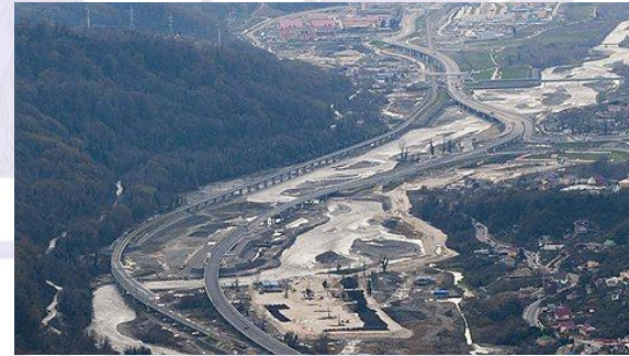
Совмещенная автомобильная и железная дорога Адлер - Альпика-Сервис
