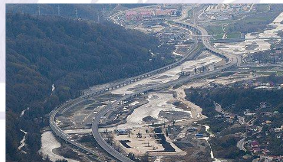
Совмещенная автомобильная и железная дорога Адлер - Альпика-Сервис
