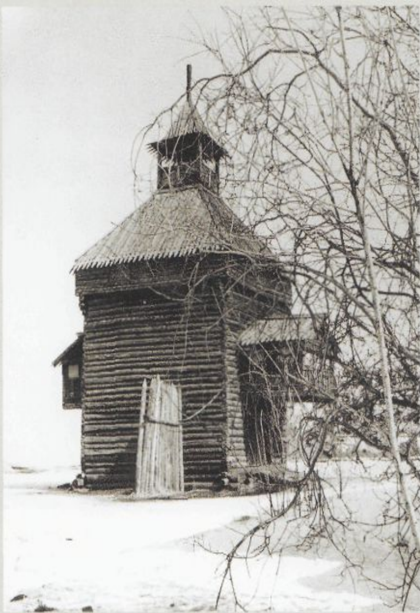
Восточная надвратная башня Якутского острога (1686 г.)
