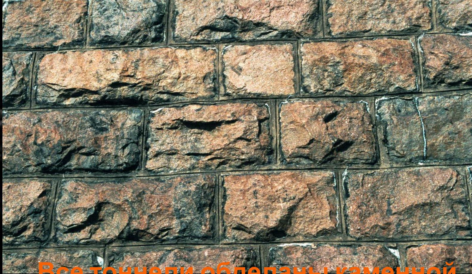
**Все тоннели обделаны каменной кладкой на цементном растворе. Стены и свод выкладывались из отборного бутового камня (камень неопределенной формы) горизонтальными рядами**
