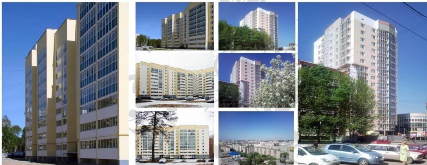
жилой дом на ул. Уральских Рабочих, 42 (Верхняя Пышма)
