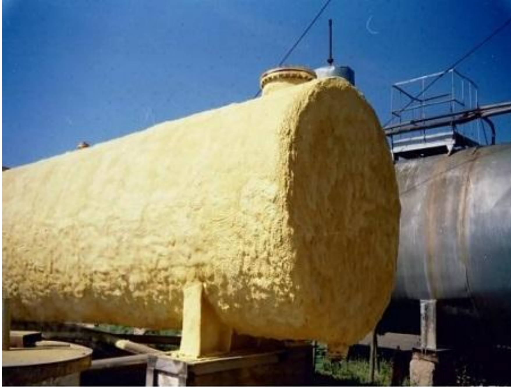
Теплоизоляция цистерны
