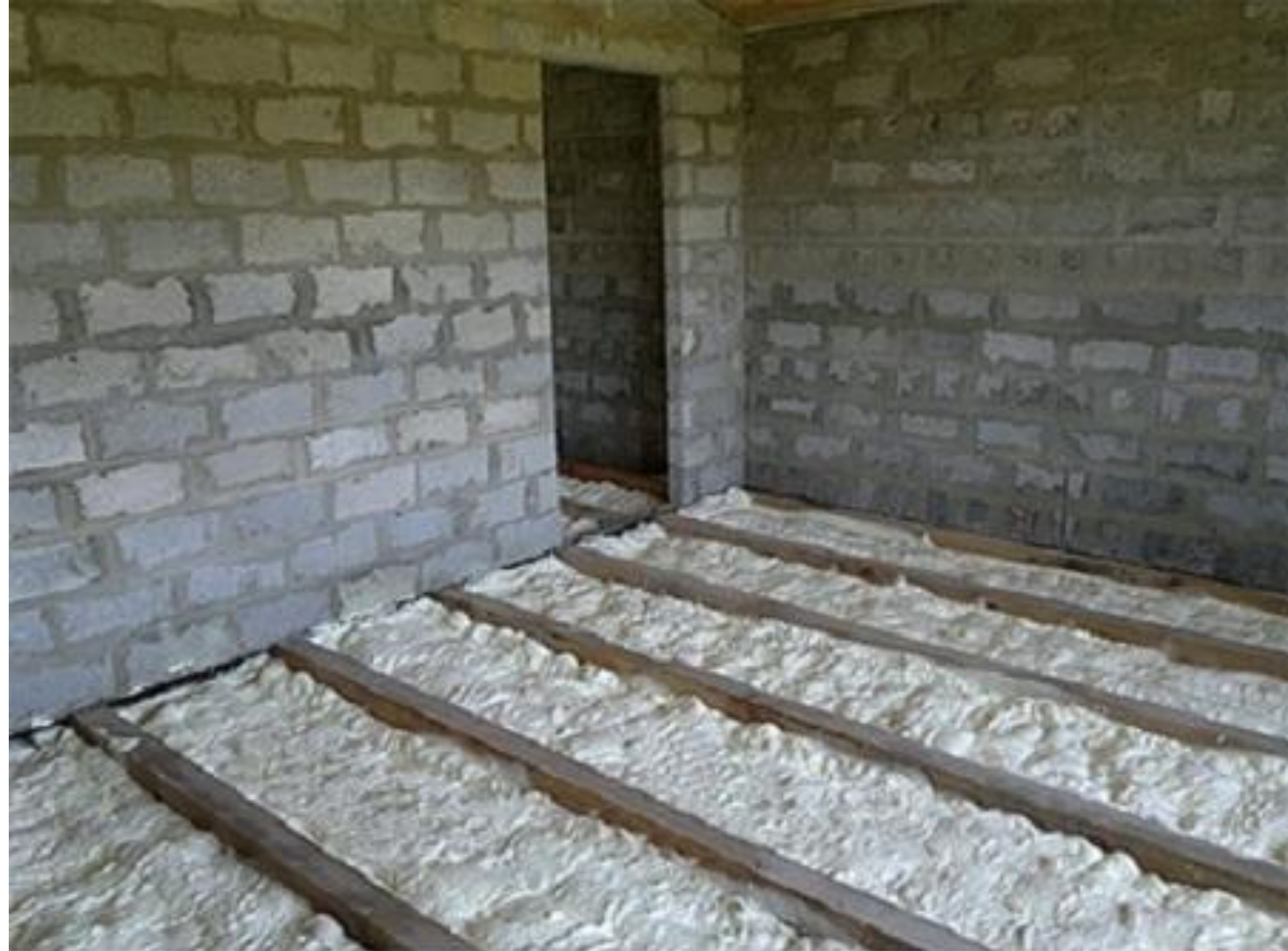
Теплоизоляция пола
