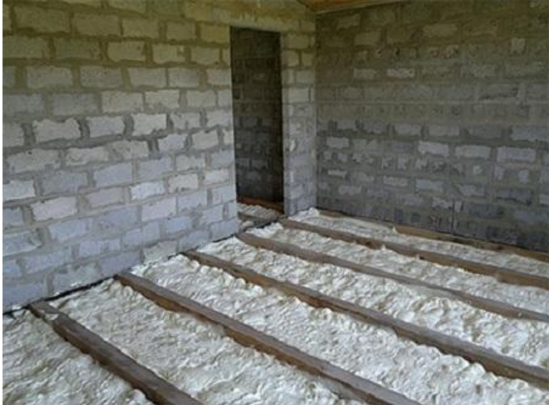
Теплоизоляция пола
