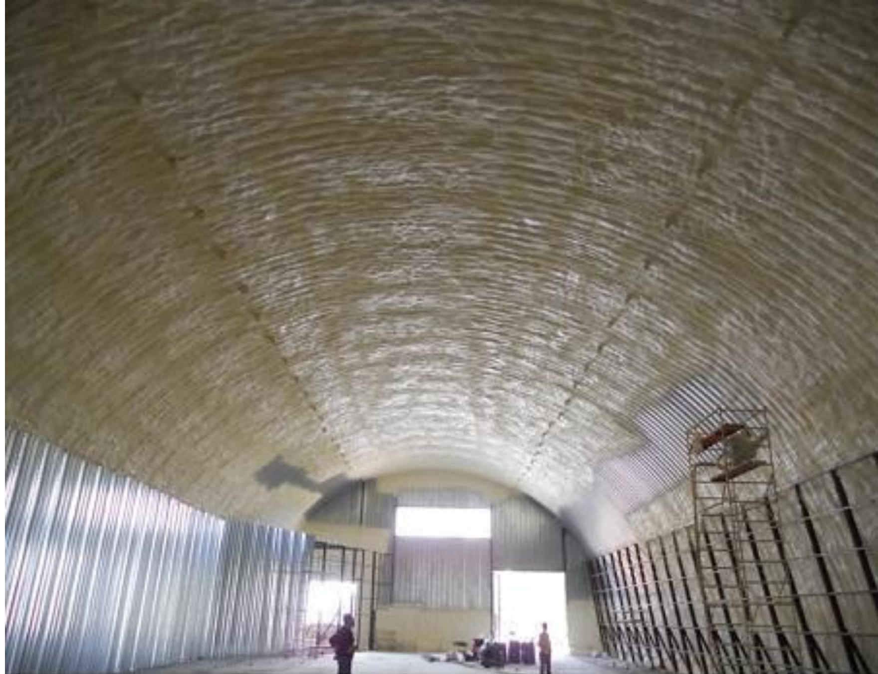
Утепление пенополиуретаном ангара
