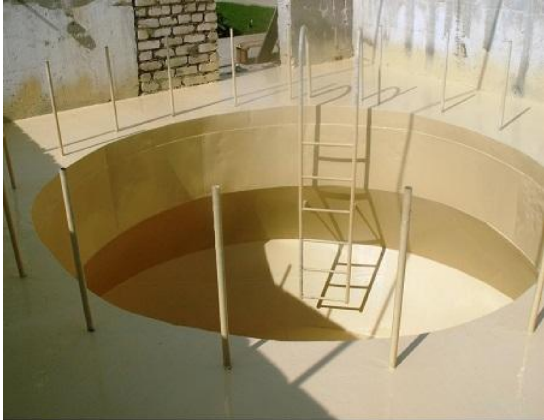
Утепление пенополиуретаном бассейна
