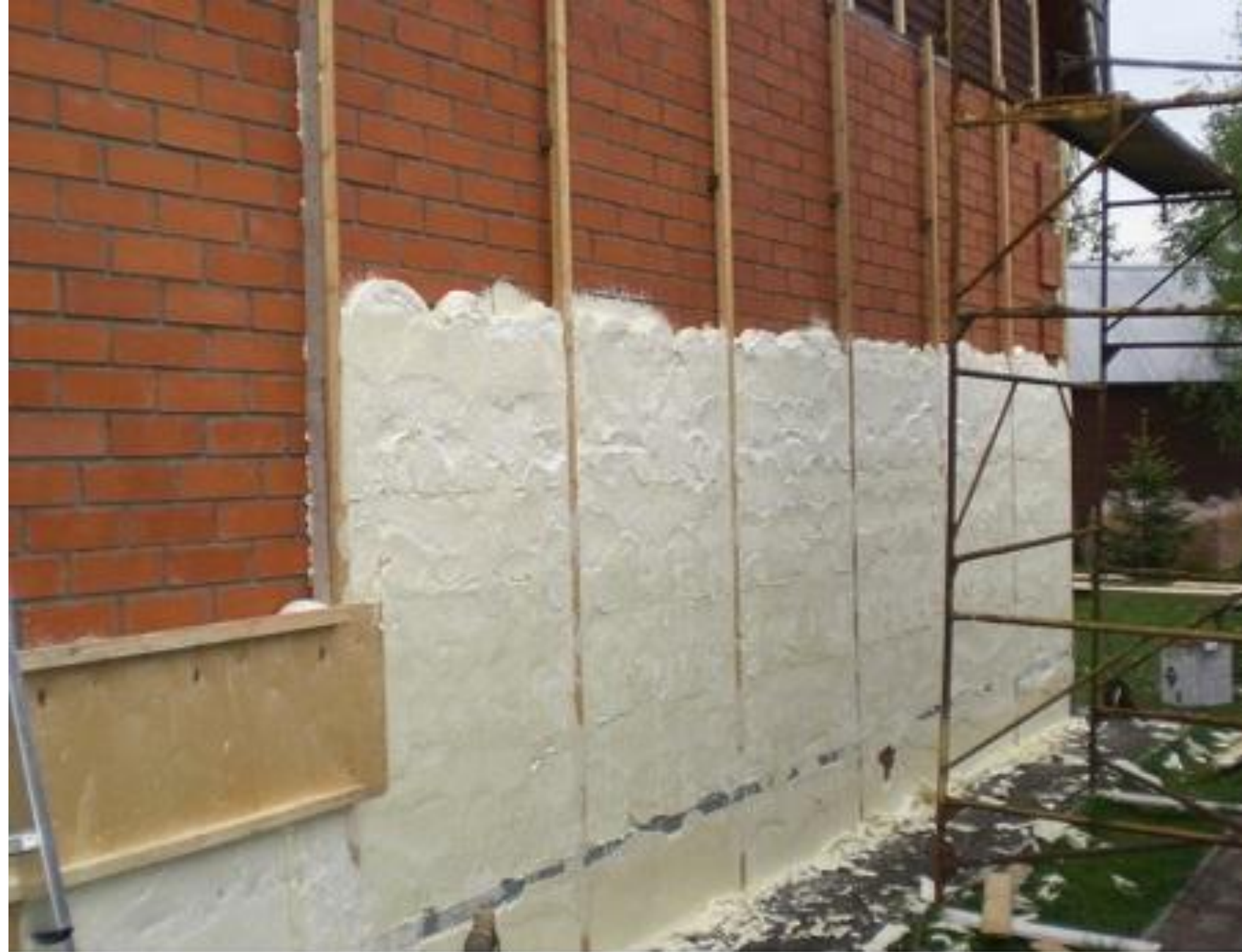
Наружная теплоизоляция стен и цоколя кирпичного дома
