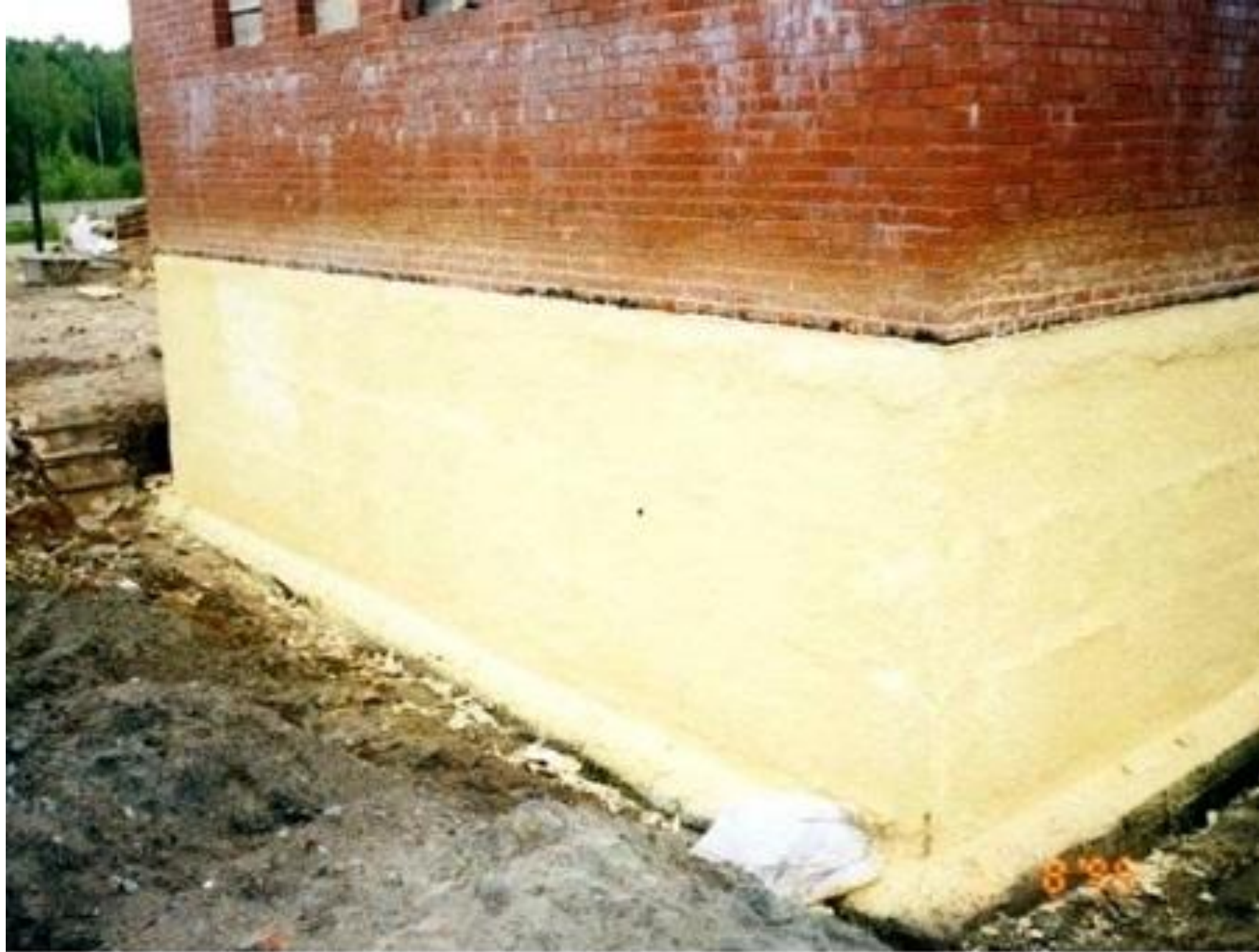
Тепло - гидроизоляция фундамента
