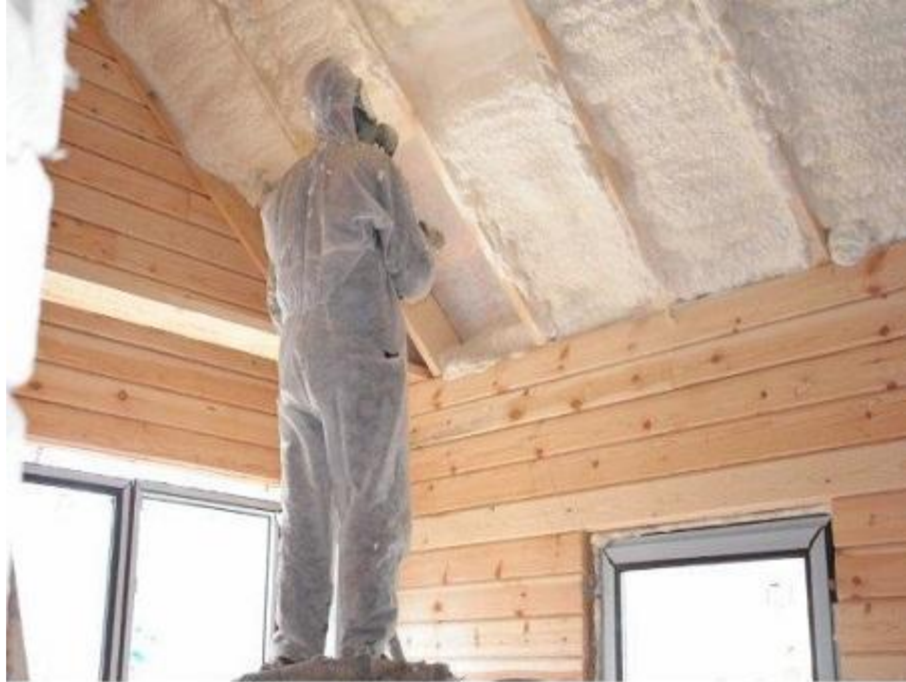
Внутренняя теплоизоляция кровли дома
