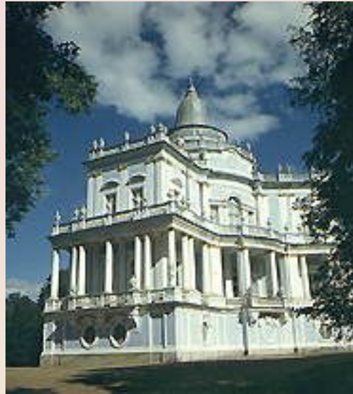
Ломоносов. Павильон Катальной горки (северное крыло).
