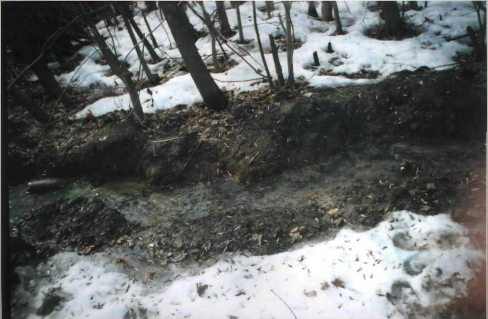
ФОТО № 3 ДОННАЯ ЭРОЗИЯ
