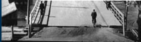
Мост через Клязьму
