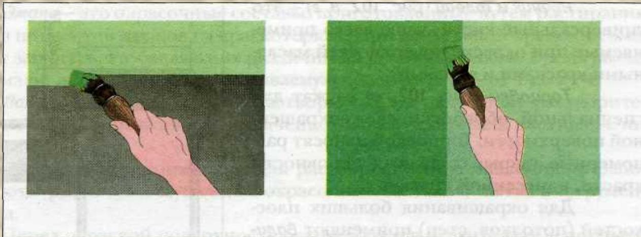
Направление штрихов при окраске играет существенную роль. Если стену окрашивают два раза, то первые штрихи ведут параллельно полу, а при окрашивании вторым слоем - вертикально от потолка к полу. При окрашивании потолка штрихи последнего слоя проводят параллельно световым лучам, падающим из окна.
