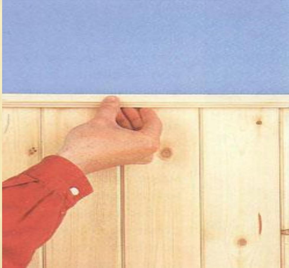
Для получения более красивой отделки к передней кромке этой рейки можно прикрепить фигурный профиль. Чтобы крепления не были видны, посадите профиль на клей. Последней операцией является крепление плинтуса к нижней части панели.
