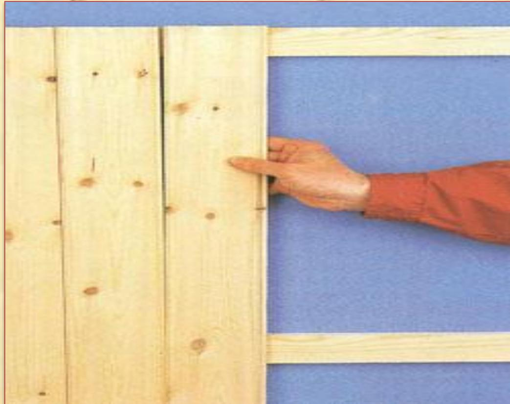
Обрежьте панели точно по требуемой длине, от уровня пола до верхнего края верхней рейки. Панели собираются вместе вручную — шпунт одной панели вставляется в паз другой.
