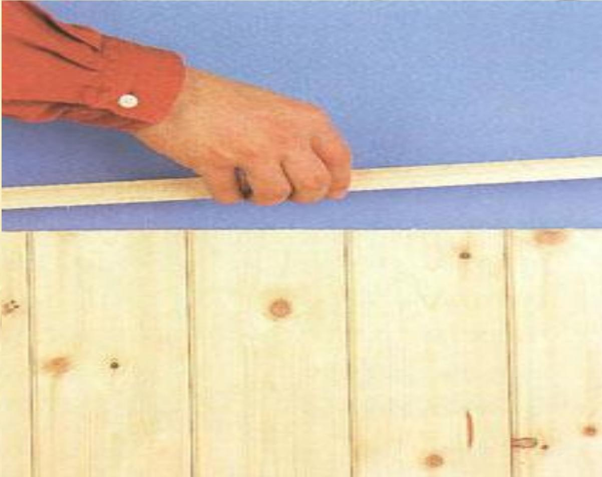
Для отделки верхнего торца шпунтованных панелей требуется рейка дадо. Здесь использован еще один отрезок деревянной рейки, прибитый так, чтобы он закрывал верхнюю часть верхней рейки и верхний торец панелей.
