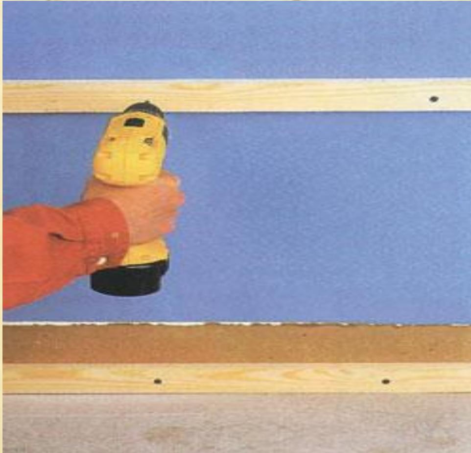
Просверлите отверстия и закрепите рейки вдоль приводных линий. Если рейки не достаточно длинные, состыкуйте их. Для крепления реек можно использовать анкерные болты для бетона, как показано здесь, или обычные шурупы и деревянные пробки
