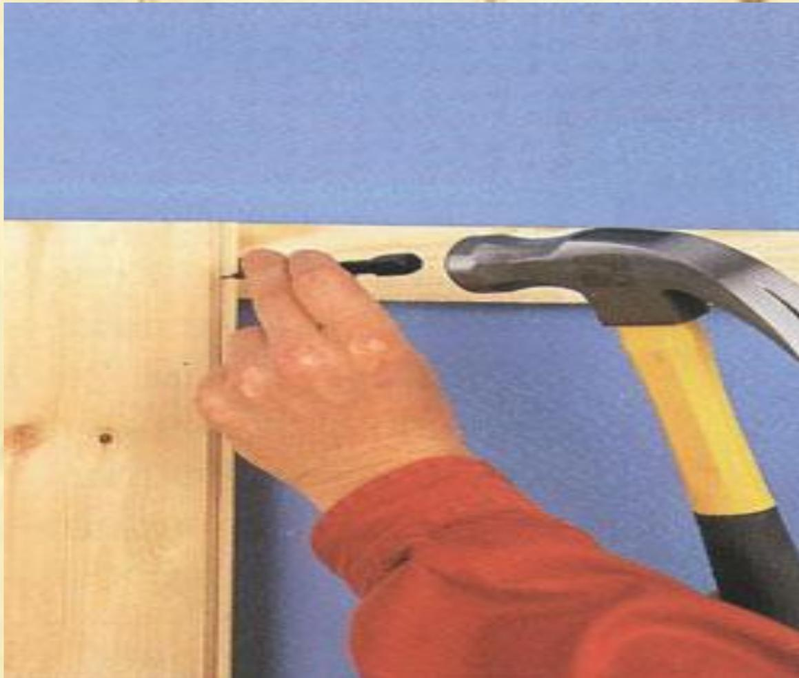
Установив панель, вбейте через шпунт в рейку под ним гвоздь под углом  $45^\circ$ . Добойником глубоко осадите гвозди. Закрепите панель ко всем трем рейкам. Каждая следующая панель будет закрывать крепления предыдущей
