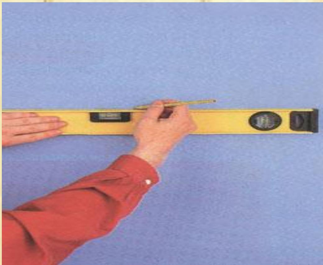
По спиртовому уровню проведите через намеченные точки горизонтальные линии. Они будут служить направляющими для крепящихся к стене реек. Чтобы панели точно стыковались между собой, эти линии должны быть строго горизонтальными.
