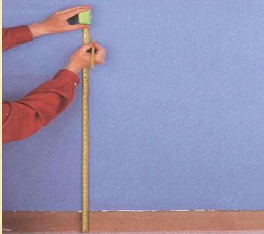
Сначала нужно произвести разметку стен. С помощью рулетки отмерить расстояние между брусками. Оно не должно превышать 50 см. При вертикальной укладке панелей планки каркаса устанавливают по горизонтали. Вертикальное расположение направляющих (брусков) применяют при горизонтальном монтаже панелей. Если обшивка крепится наклонно (по диагонали), несущая конструкция должна иметь и вертикальные и горизонтальные планки.
