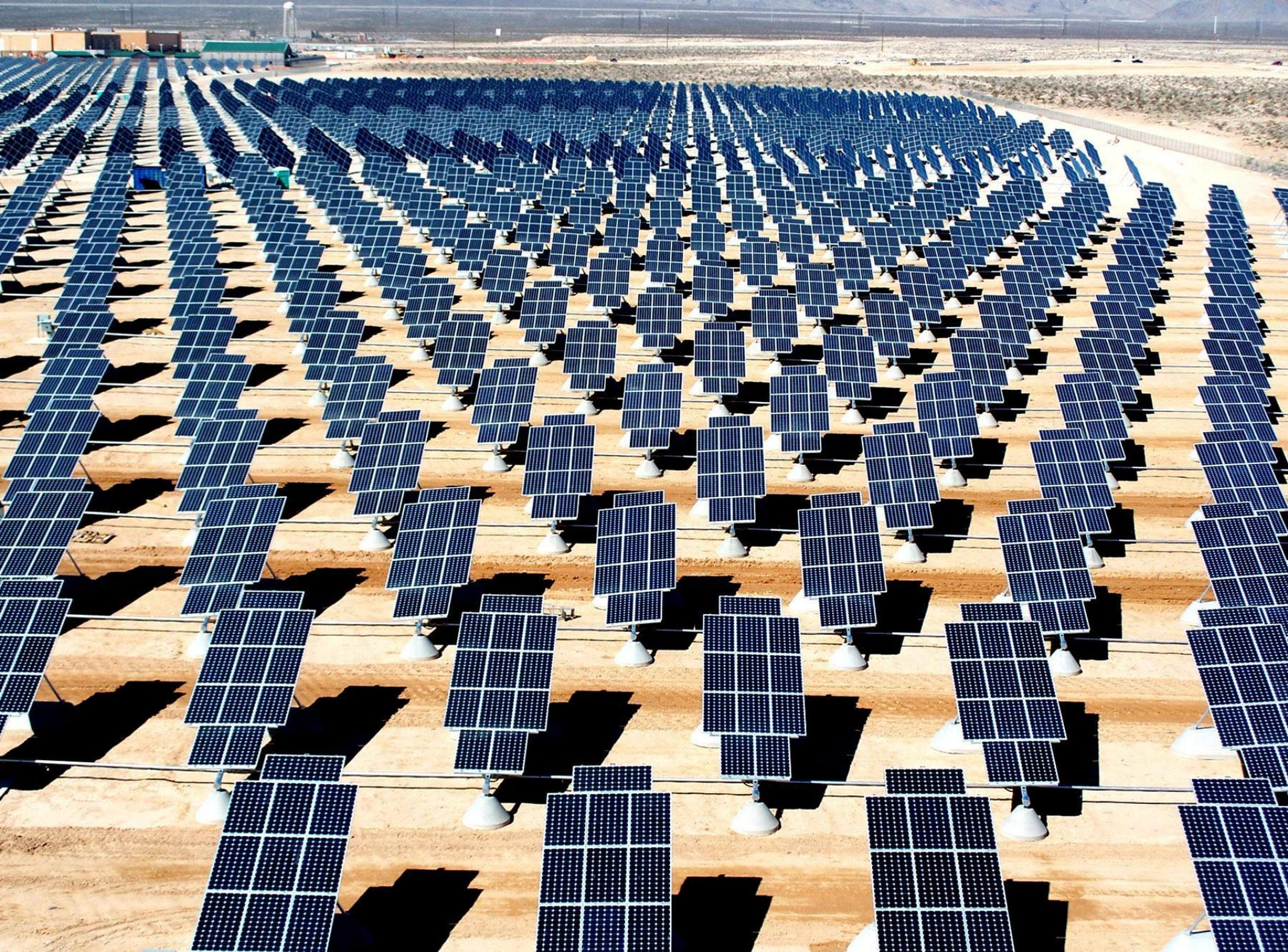
Фотоэлектрический эффект возникает в солнечном элементе при его освещении светом в видимой и ближней инфракрасной областях спектра. В солнечном элементе из полупроводникового кремния толщиной 50 мкм поглощаются фотоны, и их энергия преобразуется в электрическую посредством p-n соединения.
