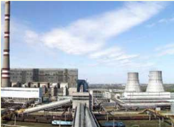
Паровая турбина установлена на Тюменской ТЭЦ-1
