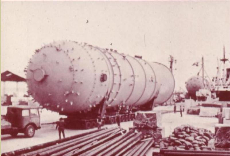
Тяжеловесные грузы (до  $5000000\text{H}$ ) перевозят по автострадам и железным дорогам на многоосных платформах. Их «пассажиры» - части корпусов океанских судов, локомотивы турбогенераторы, энергоблоки и так далее.
