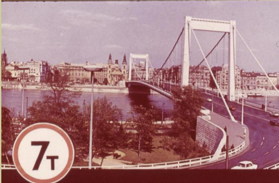
Такой знак при въезде на мост означает, что максимальный вес транспортной единицы с грузом не должен быть больше 7 тонн (70 000Н), чтобы не превысить допустимую силу давления на опоры моста.
