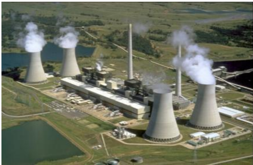
Атомная электростанция во Франции
