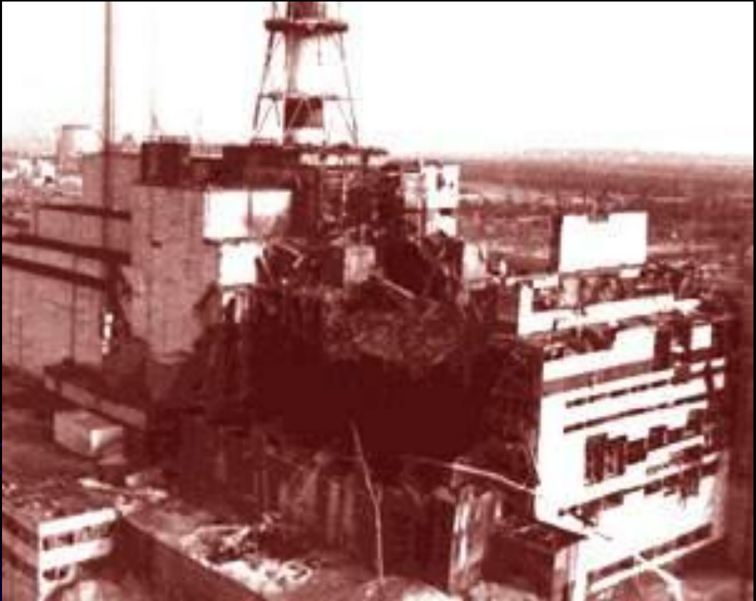
Разрушенный 4ый реактор АЭС
