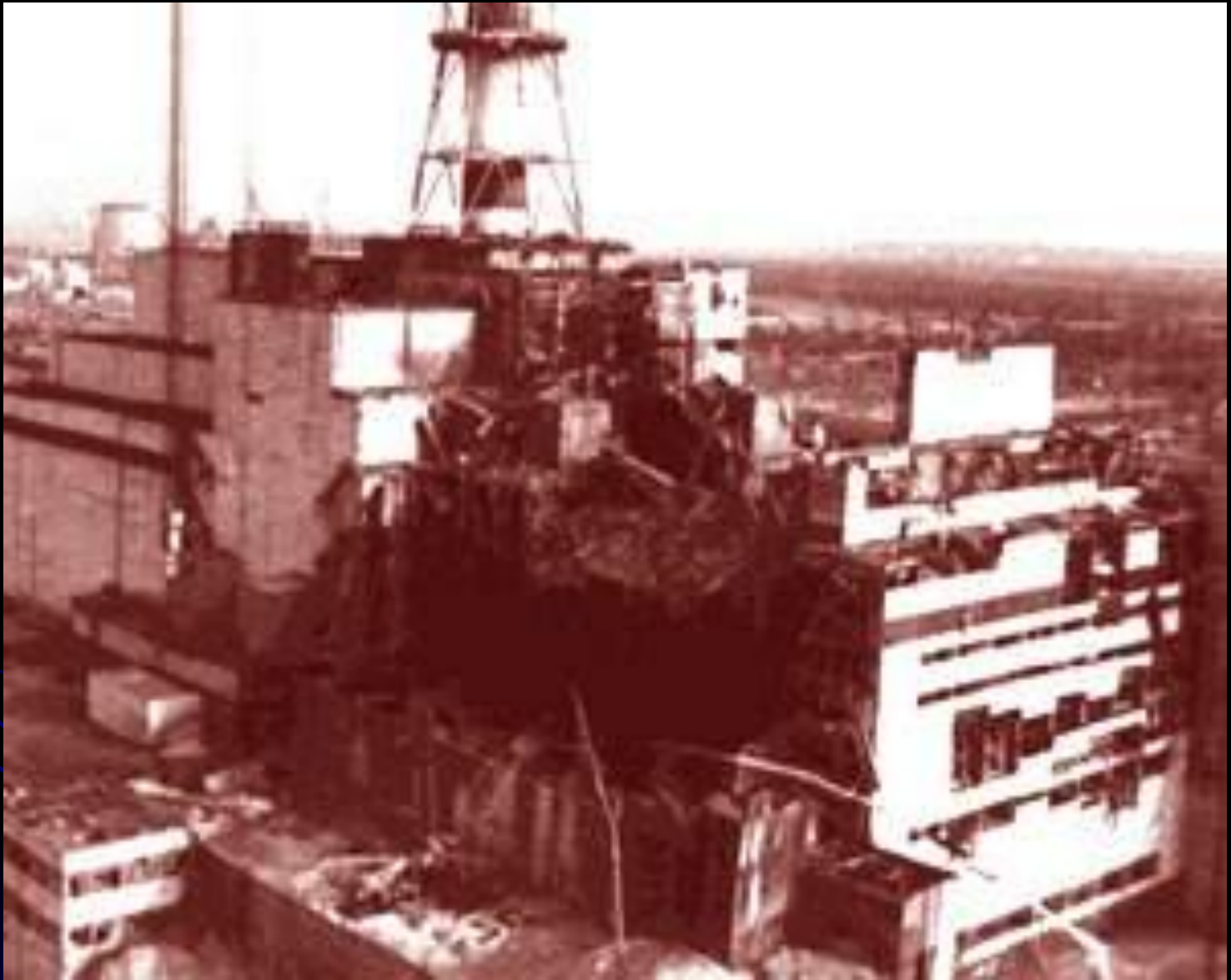
Разрушенный 4ый реактор АЭС
