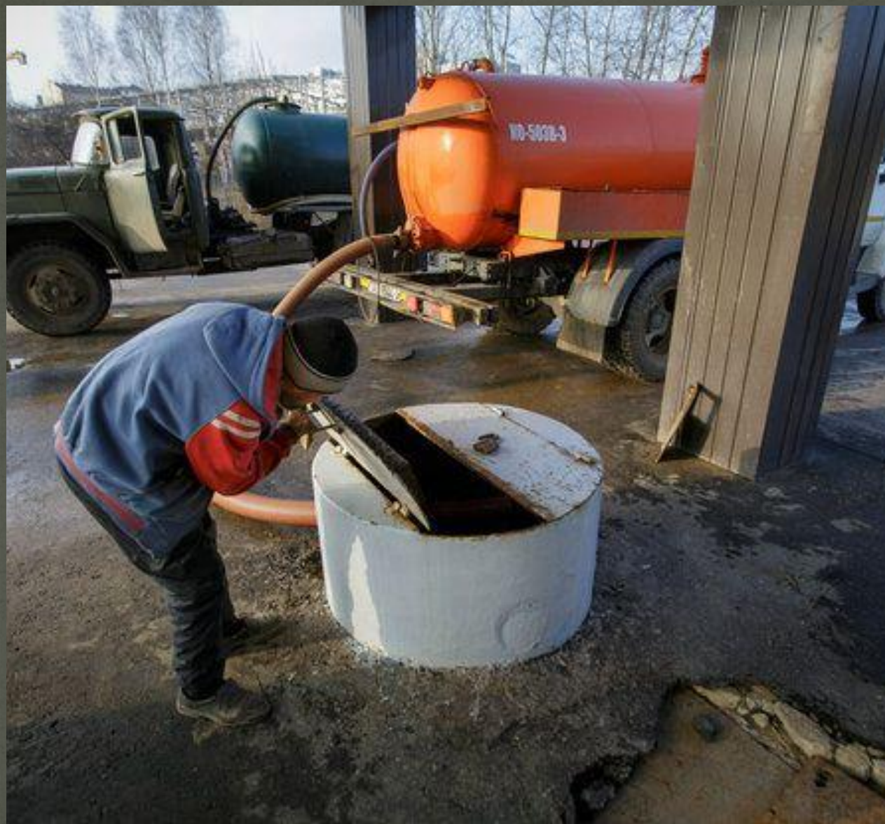
Откачка резервуаров на АЗС
