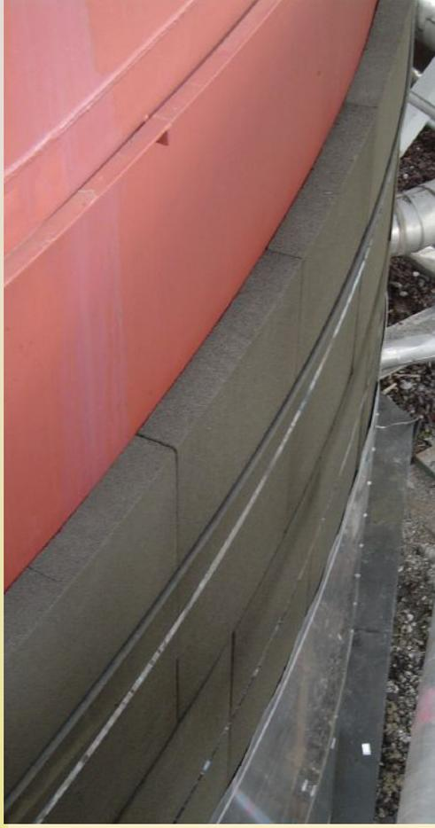
**Пеностекло «НЕОПОРМ» применяется для теплоизоляции железобетонных и стальных резервуаров без ограничения объема**
