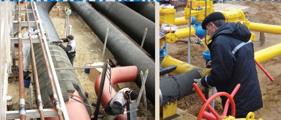
Пеностекло «НЕОПОРМ» применяется для утепления трубопроводов любого диаметра и оборудования с рабочими температурами от **-196** до **+300** градусов
