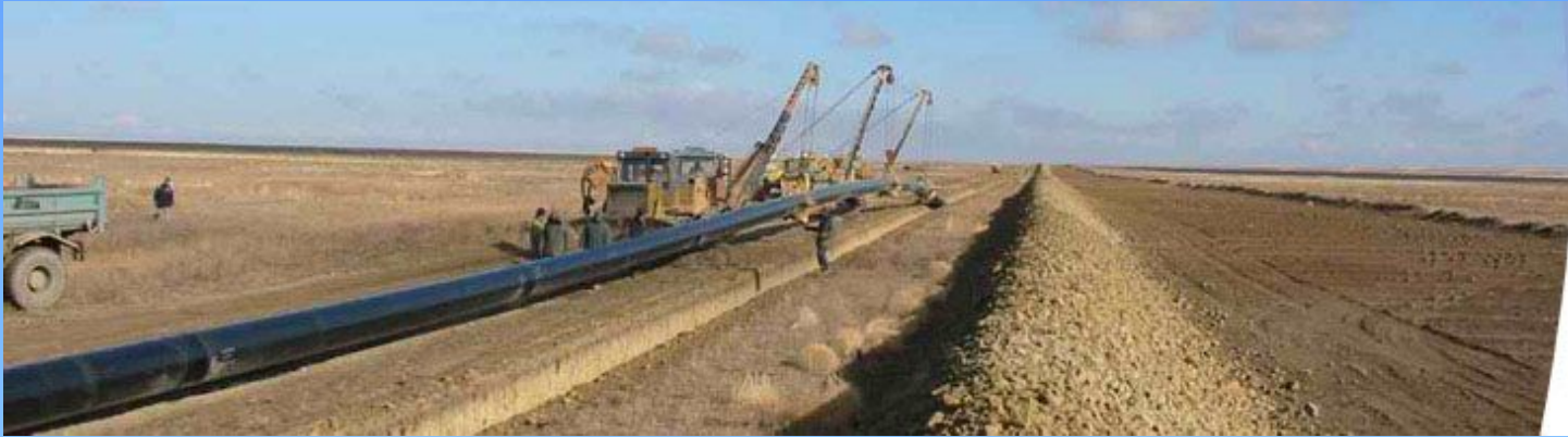
Укладання нафтопроводу.
