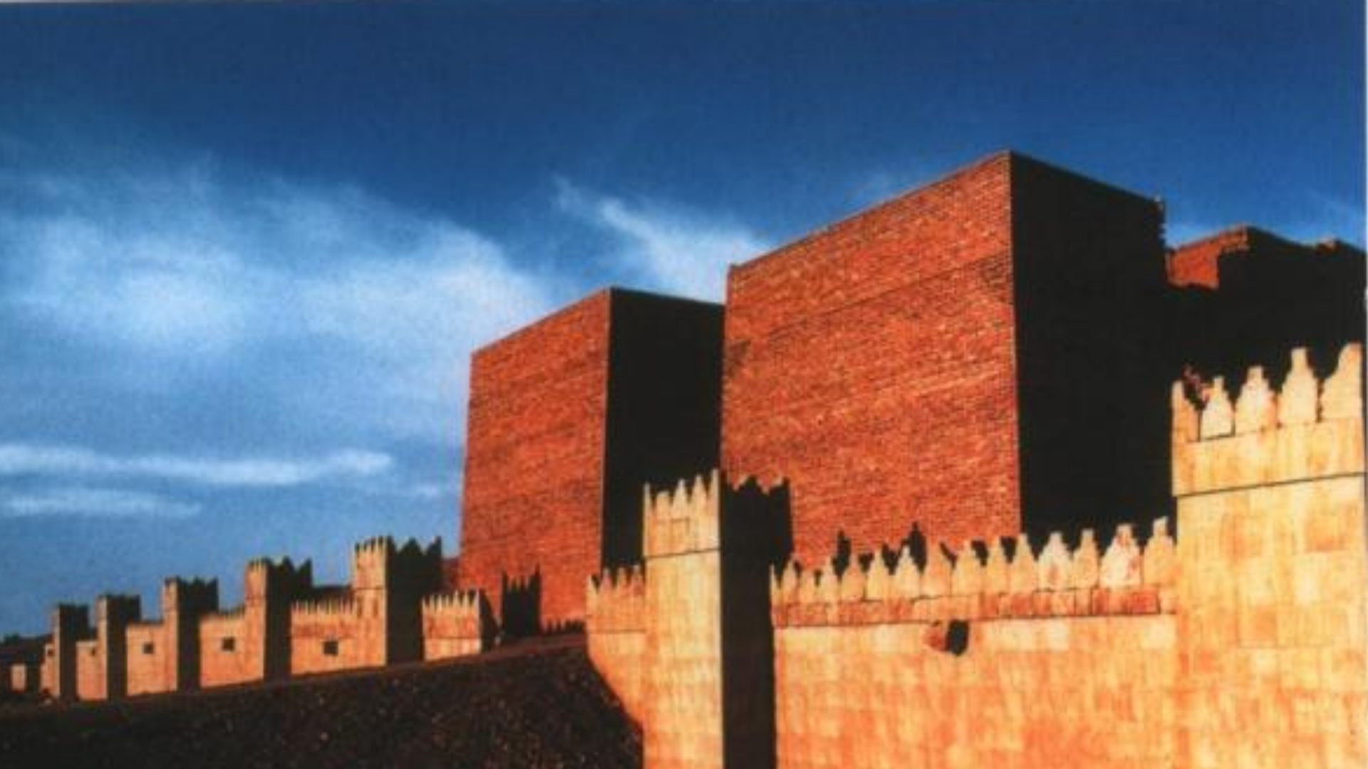
Городские укрепления Нинезии. Построенные в 700-696 гг. до н.э., они состояли из внешней стены с башнями и зубцами, сложенной из известковых блоков и внутренней - из сырцового кирпича на каменном основании
